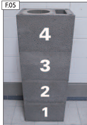
Vier Mantelsteine jeweils in Dünnbettmörtel versetzen.
