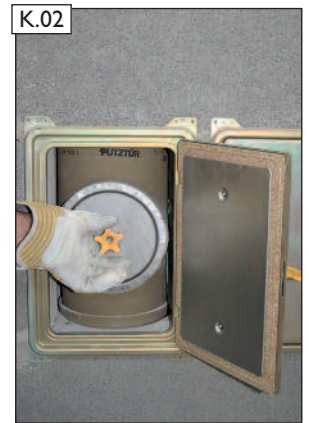
Standardrevisionsverschluss einsetzen.
