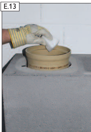
E.13 Steckverbindung säubern.
