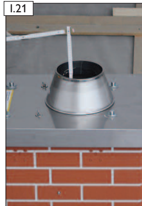
I.21 ... Zuschnittlänge für das letzte Profilrohr ermitteln.
