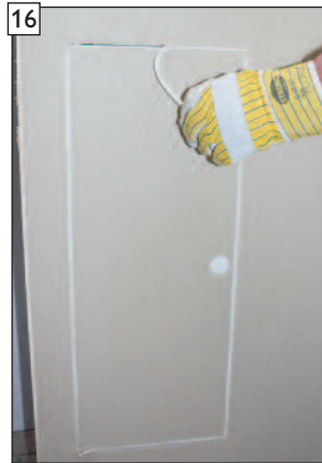
16 Sobald der Oberputz beginnt „anzuziehen“ ist die Schutzdichtung zu entfernen.
