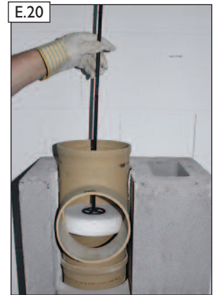
Reste von RAPID-fugendicht mit Fugenglätter abstreifen.
