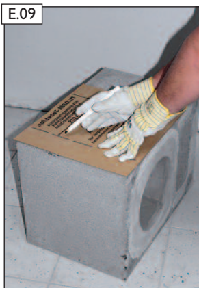
E.09 Schablone außen anlegen, Mantelsteinöffnung anzeichnen.
