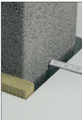
Montageausparung allseitig 3 cm größer als Mantelsteinmaß.
