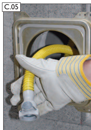
C.05 Kupplungsteil des Kondensatauffangbeutels auf den 3/4" Siphonschlauch aufstecken.
