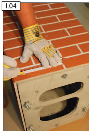
Ermittelte Abmessungen C des Mantelsteins mittig auf den Stülpkopf übertragen.
