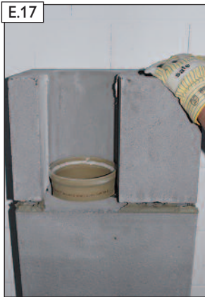
Öffnungsstein versetzen.
