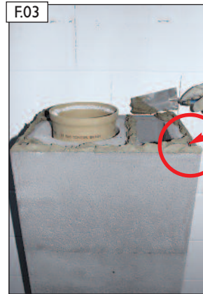
Dünnbettmörtel auftragen.
