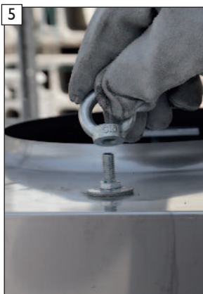
5 Ringösen können nun entfernt werden.
