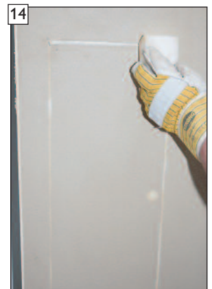
14 Schutzdichtung mit Schwamm nacharbeiten.
