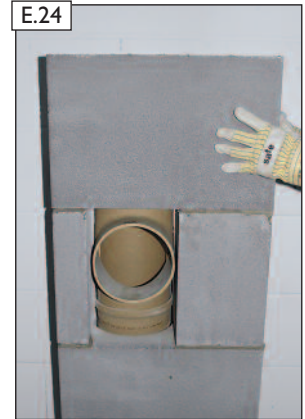
Nächsten Mantelstein versetzen.
