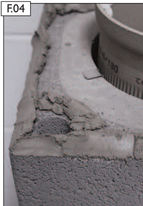
ACHTUNG! Auf geschlossenen Stegbereich achten!
