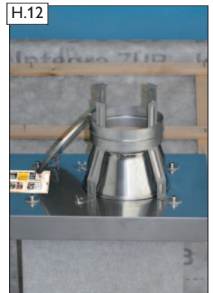
Der Revisionsdeckel ist mit einer Drahtschlinge, als „Absturzsicherung“, verbunden. Die Drahtschlaufensicherung mind. einmal im Jahr überprüfen und ggf. erneuern.
