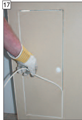
17 Schutzdichtung dabei immer vorsichtig und langsam herausziehen.
