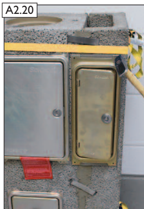
Vorbereitete Revisionstür auf Lüftungsmodul annageln.
