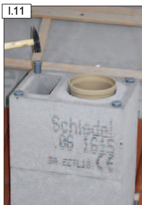
I.11 HEB-Spezialdübel in die Bewehrungskanäle einschlagen.
