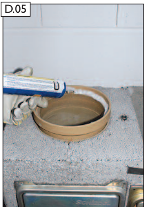
D.05 RAPID-fugendicht satt auf Adapterring auftragen.
