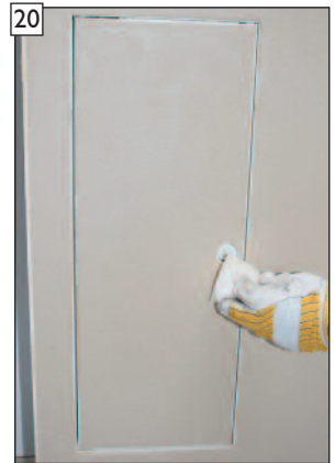
20 Putzkante zur Abdeckkappe ggf. mit Schwamm nacharbeiten.
