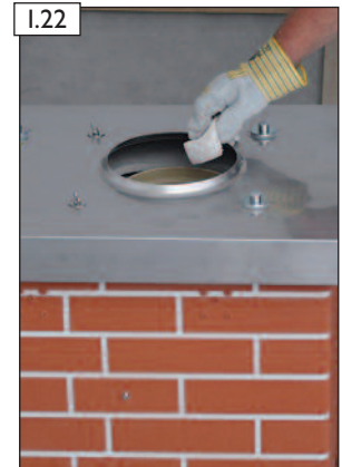
I.22 Steckverbindung säubern.
