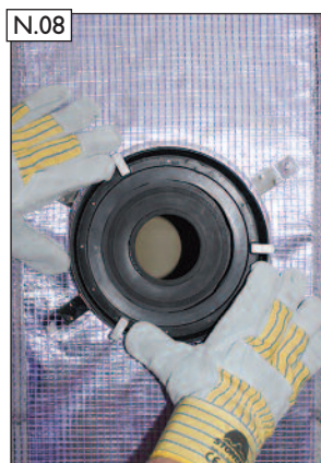
Äußeren Steckadapter mit Gleitmittel in Putzring einsetzen.
