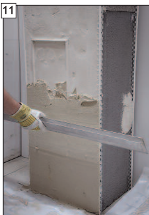
11 Bauseitigen Oberputz auftragen.
