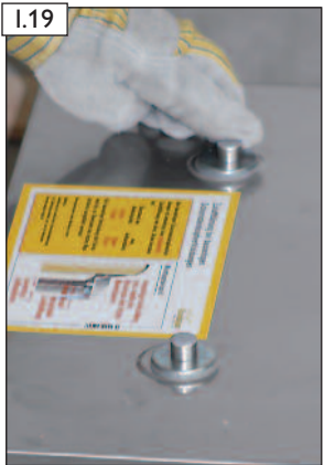
Abdeckkappen in Inbus-schrauben eindrücken.
