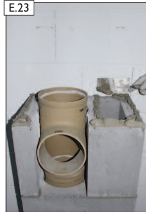
Dünnbettmörtel auftragen.
