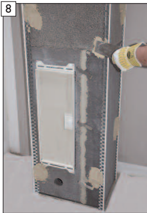
8 Anbringen der bauseitigen Putzschienen.
