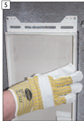
5 Schutzdichtung weiter einbringen und auf „planen“ Sitz achten.
