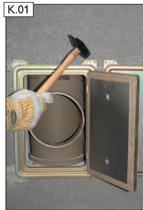
Putztür am Mantelstein annageln.
