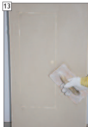
13 ... dabei die Schutzdichtung bündig freireiben.
