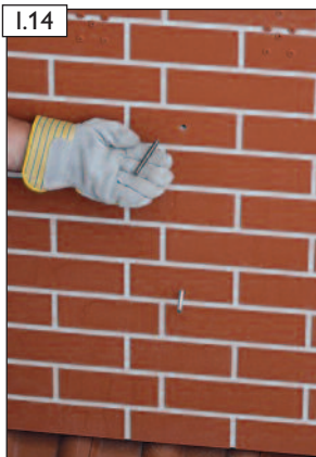
Gewindestifte in die seitlichen Gewindebuchsen des Stülpkopfes eindrehen.
