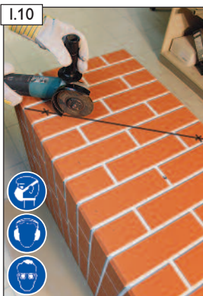
Schrägschnitt mit Flex herstellen.
