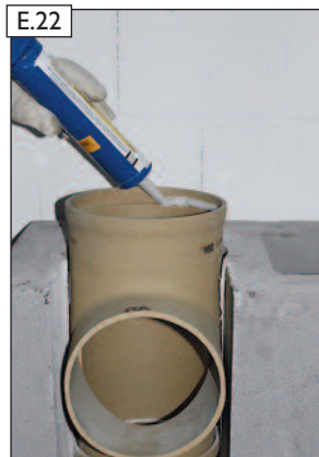
RAPID-fugendicht im Bereich der Steckverbin- dung satt auftragen.
