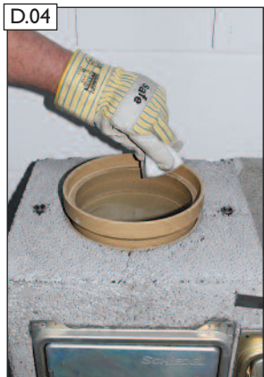
D.04 Steckverbindung säubern.
