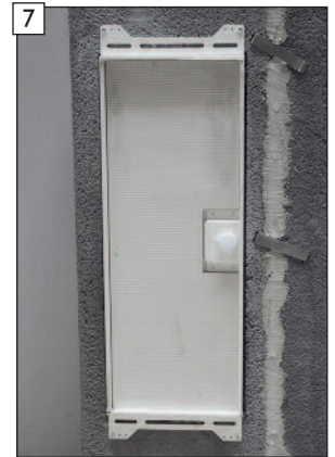
7 Fertigansicht mit vollständig eingebrachter Schutzdichtung.
