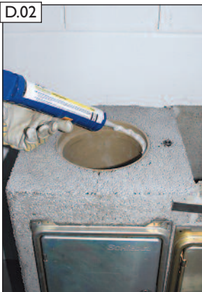
D.02 RAPID-fugendicht satt auftragen.
