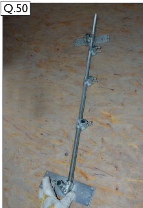
Q.50 Zweiten Schornsteinhalter vorbereiten. Spannkreuze und Sparrenhalter lose auf die Gewindestange auf-fädeln.
