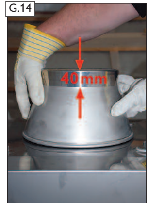
G.14 Konus bis ca. 2-3 mm auf Zuluftkopfplatte aufschieben.
