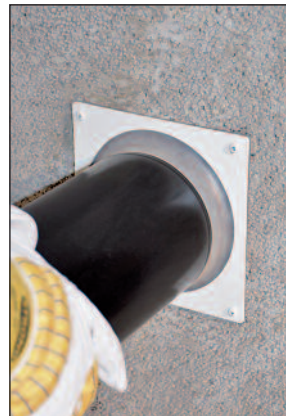
Bauseitige Zuluftleitung in BlowerDoor-Zuluftblende einschieben.
