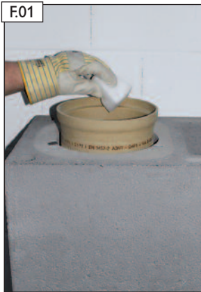
Steckverbindung säubern.
