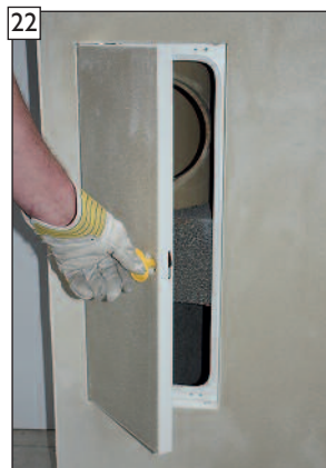
Funktionskontrolle! Überprüfen Sie die Schließung der BlowerDoor-Design-Fertigfußtür und entfernen Sie ggf. Putzreste an Türblatt und Zarge.
