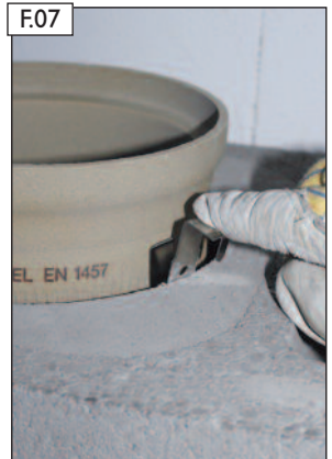
Abstandhalter (3 Stück) auf den Umfang verteilt in die integrierte Wärmedämmung aus Schaumbeton eindrücken.
