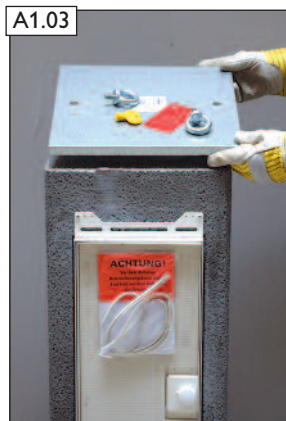
Ringschrauben und Abdeckung entfernen.
