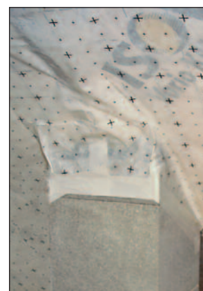
Bauseitiger Anschluss an DB-Folie
