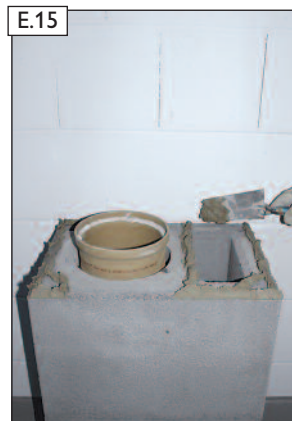
E.15 Dünnbettmörtel auftragen.
