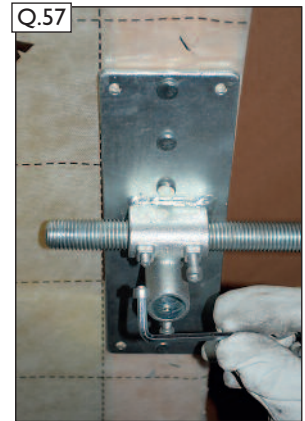
Q.57 Gewindestange fixieren. Dazu die Abreißschrauben an bei den Sparrenhaltern mit Inbusschlüssel (F) anziehen bis der Schraubkopf an der Sollbruchstelle abreißt. Erst danach Spannwinkel fixieren (siehe Bild Q.58).
