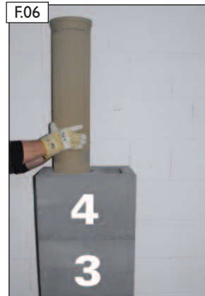
Profilrohr (L = 133 cm) einsetzen.
