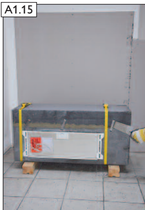
Fuge auf Vorder- und Rückseite vollständig und dicht nachspachteln.
