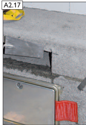
Überschnitte am Lüftungsmodul ebenfalls vollständig ausspachteln.
