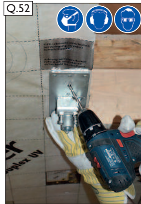
Q.52 Sparrenhalter anhalten und Nagellöcher gemäß dem Nagelbild (siehe oben) vorbohren.
