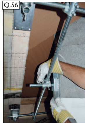
Q.56 Spannwinkel ausrichten und vorfixieren.
