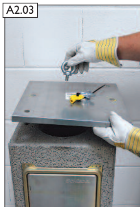
Ringschrauben und Abdeckung entfernen.
