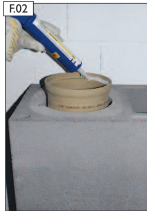
RAPID-fugendicht satt auftragen.
