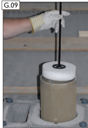
G.09 RAPID-Fugenkittreste abstreifen.
