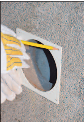
Markierung für Bohrlöcher anzeichnen und herstellen.
