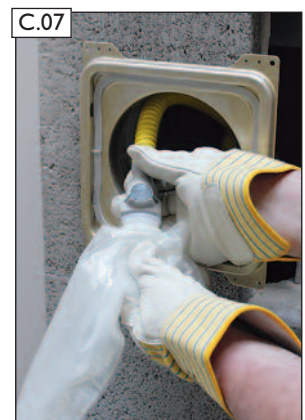
C.07 Kondensatauffangbeutel mit Kupplungsteil verbinden.
