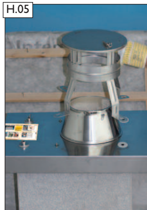
Silikondichtungen auf Zuluftkopfplatte-Edelstahl auflegen. Regenhaube „EAGLE“ aufsetzen.
