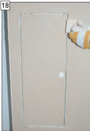
18 Putzkanten ggf. vorsichtig mit Schwamm nacharbeiten.
