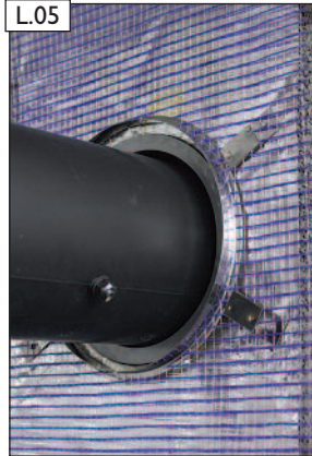
Ansicht Anschlussfutter mit bauseitig eingesteckter Verbindungsleitung.
