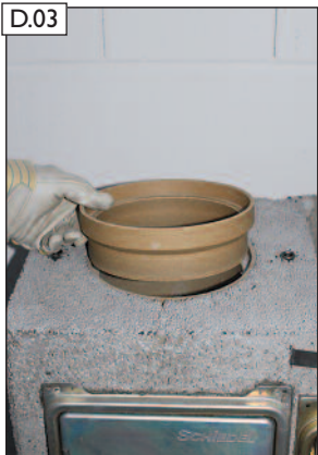
D.03 Adapterring einsetzen.
