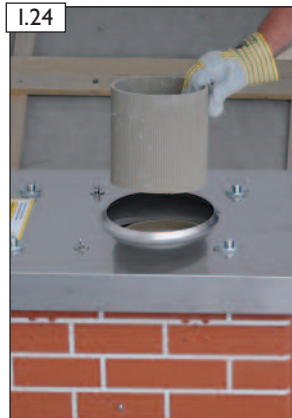
I.24 Zugeschnittenes Abschlussprofilrohr ersetzen.
