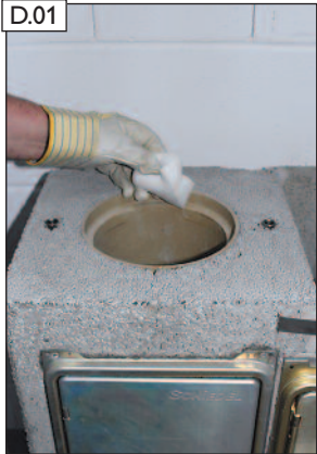
D.01 Steckverbindung säubern.
