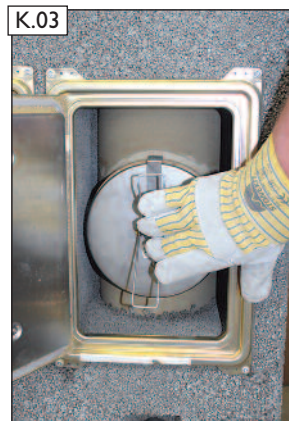
Revisionsverschluss bei Festbrennstoffbelegung.
