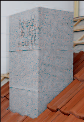
Ansicht vor Montagebeginn.
