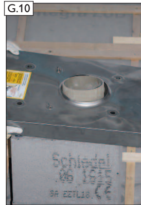
G.10 Zuluftkopfplatte-Edelstahl auflegen.
