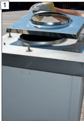
1 Adapterplatte auf Befestigungsbolzen auflegen.
