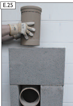
Profilrohr (L = 33 cm) einsetzen.
