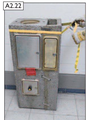
Spanngurte lösen. HINWEIS! Die Spanngurte werden im weiteren Versetzvorgang nicht mehr benötigt!
