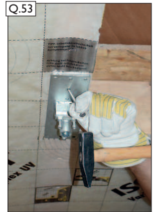
Q.53 Sparrenhalter mit Kamm-nägeln (E) ausnageln.
