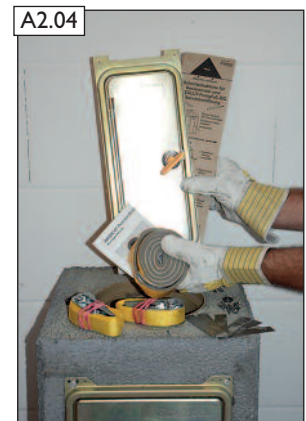
Restliches Zubehör aus dem Fertigfuß entnehmen.
