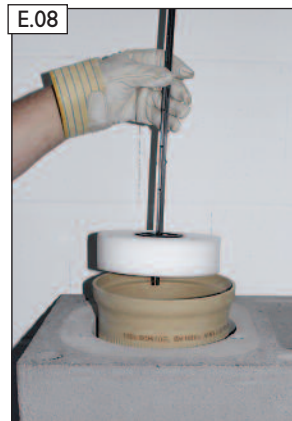
E.08 Reste von RAPID-fugendicht mit Fugenglätter abstreifen.
