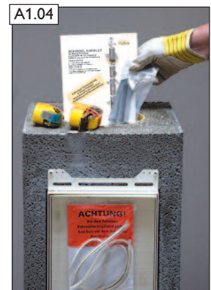
Restliches Zubehör aus dem Fertigfuß entnehmen.
