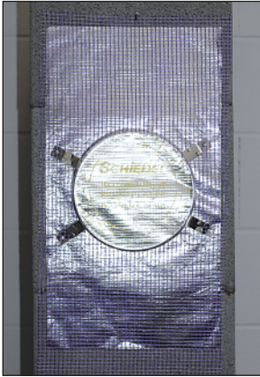
Ansicht vor Montagebeginn.
