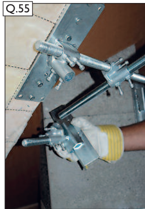
Q.55 Gewindestange in Spannkreuze des oberen und unteren Schornsteinhalters einfädeln und dabei das Spannkreuz mit dem 45° Spannwinkel mit auffädeln.
