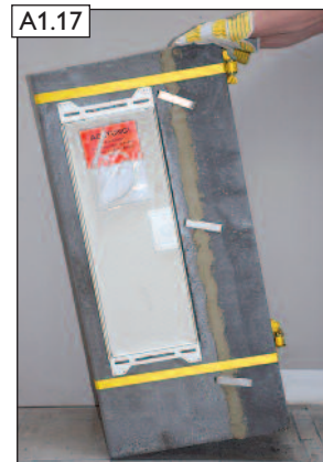
Der Fertigfuß kann nun sofort in vorbereitetes Mörtelbett versetzt werden.
