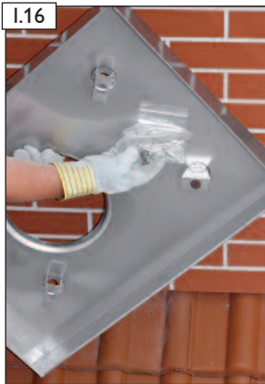
Befestigung für Regenhaube von der Edelstahl-zuluftplatte entnehmen.
