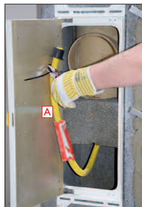
Ableitung (A) zum Abwasserkanal bauseits erstellen.
