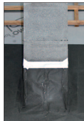
Bauseitiger Anschluss an USB-Folie
