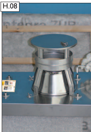
Regenhaube „EAGLE“ mit der Zuluftkopfplatte-Edelstahl verschrauben.
