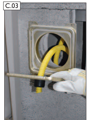
C.03 BlowerDoor-Kondensatblendentürblatt abnehmen und Adapter für HT-Rohrverbindung DN40 mit Siphonschlauch herausziehen.
