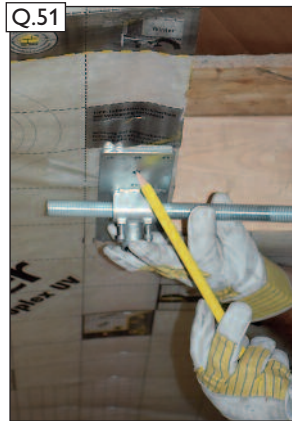
Q.51 Aufgefädelte Einzelteile zum einrichten anhalten. Einbauposition für den Sparrenhalter markieren. Danach Einzelteile ausfädeln.
