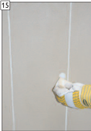
15 Ebenso die Abdeckkappe des Türverschlusses mit Schwamm nacharbeiten.
