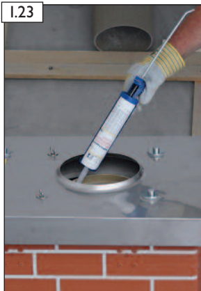
I.23 RAPID-fugendicht satt auftragen.
