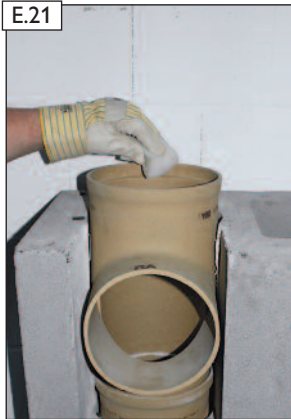
Steckverbindung säubern.
