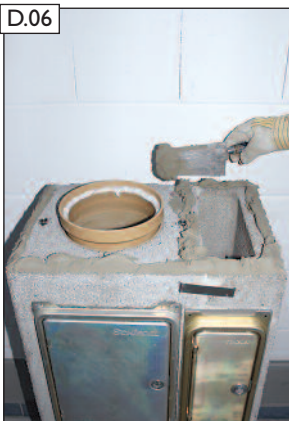
D.06 Dünnbettmörtel, auch im Stegbereich, auftragen.
