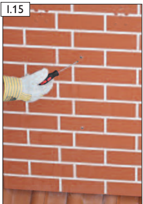
Gewindestifte kraftschlüssig verschrauben.
